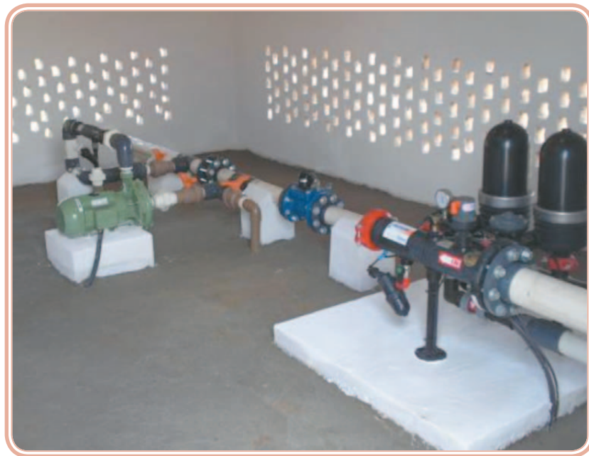
Figura 2.20: Cabeçal de controle de sistema de irrigação localizada
